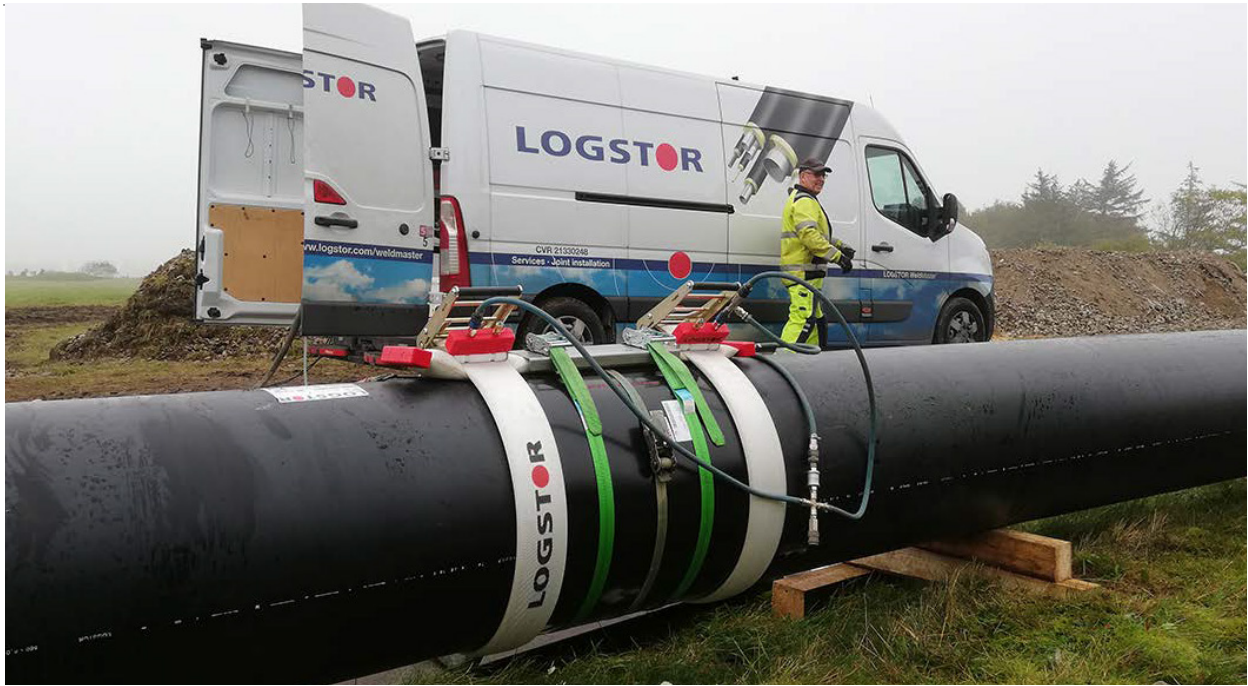
Kompletter Satz Presstools und LOGSTOR WeldMaster/ WeldMaster Light. Der Schweißdruck wird mit Luftdruck aufrechterhalten, der während der Montage kontinuierlich überprüft wird.
