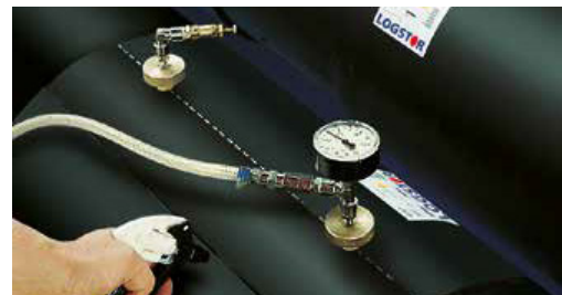
Dichtheitsprüfung vor dem Schäumen.
