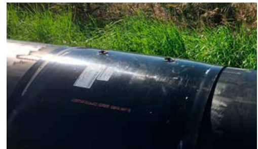
Der Barcode enthält eindeutige Daten über die Art und Abmessung der Verbindung sowie die Widerstandsfähigkeit der Schweißdrähte.
