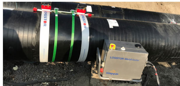
LOGSTOR WeldMaster mit zwei Schweißaggregaten. PDA/LOGSTOR Connect zur Fernsteuerung des Schweißprozesses. Der 2D-Barcode auf der Verbindung enthält die notwendigen Daten für den Schweißprozess und wird mit dem PDA/LOGSTOR Connect gescannt.
